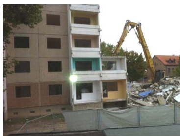
„Rückbau“ der DDR-Neubauten nebenan
